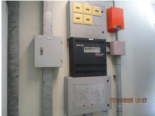
ภาพที่ 2-37 ระบบเตือนภัยอัตโนมัติ
