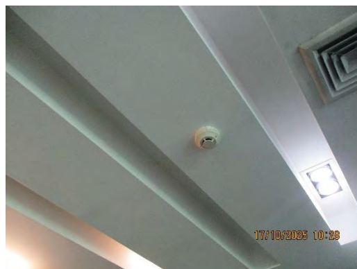
ภาพที่ 2-36 Smoke Detector
