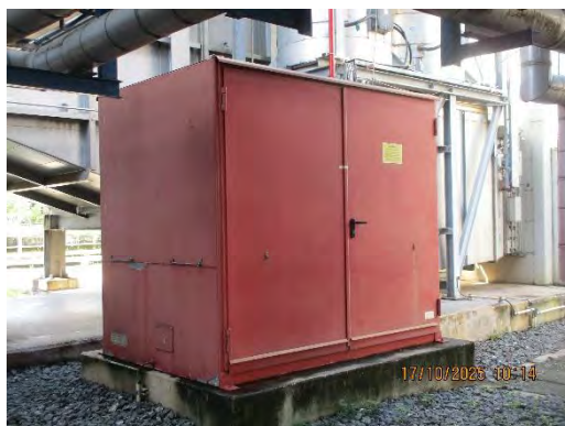
ภาพที่ 2-45 ระบบดับเพลิงชนิดคาร์บอนไดออกไซด์
