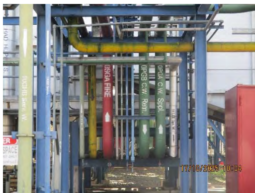
ภาพที่ 2-32 ทิศทางการไหลของระบบท่อ
