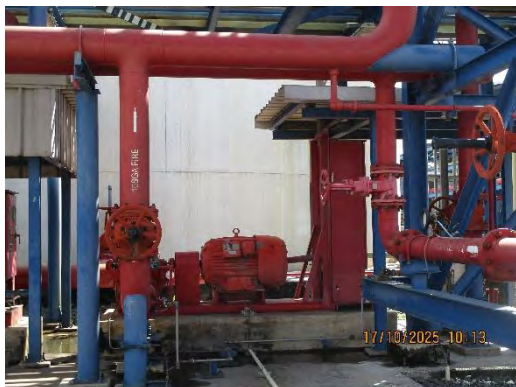
ภาพที่ 2-41 Electrical Motor Driven Fire Water Pump
