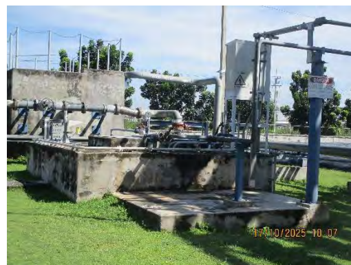
ภาพที่ 2-11 Oil Separator
